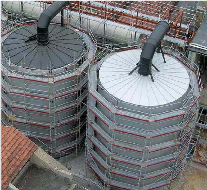
Luftreinigungsanlage, Spanien. Material: HD-PE
