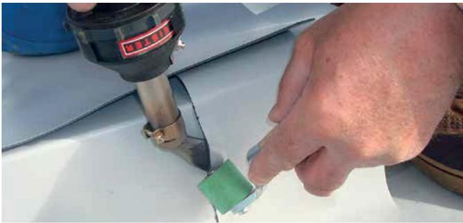
HOT JET S mit Winkeldüse beim Schweißen an einem T-Stoss auf dem Dach.
